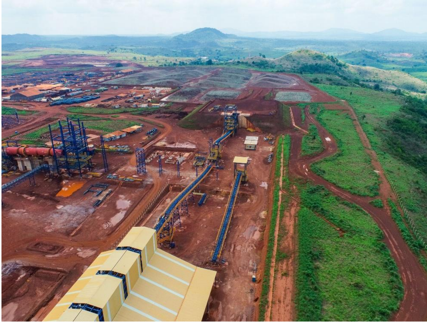
Figura 2 – Uma visão de cima do galpão de homogeneização, olhando para os britadores primário e secundário, o ROM pad e as pilhas de estoque.
