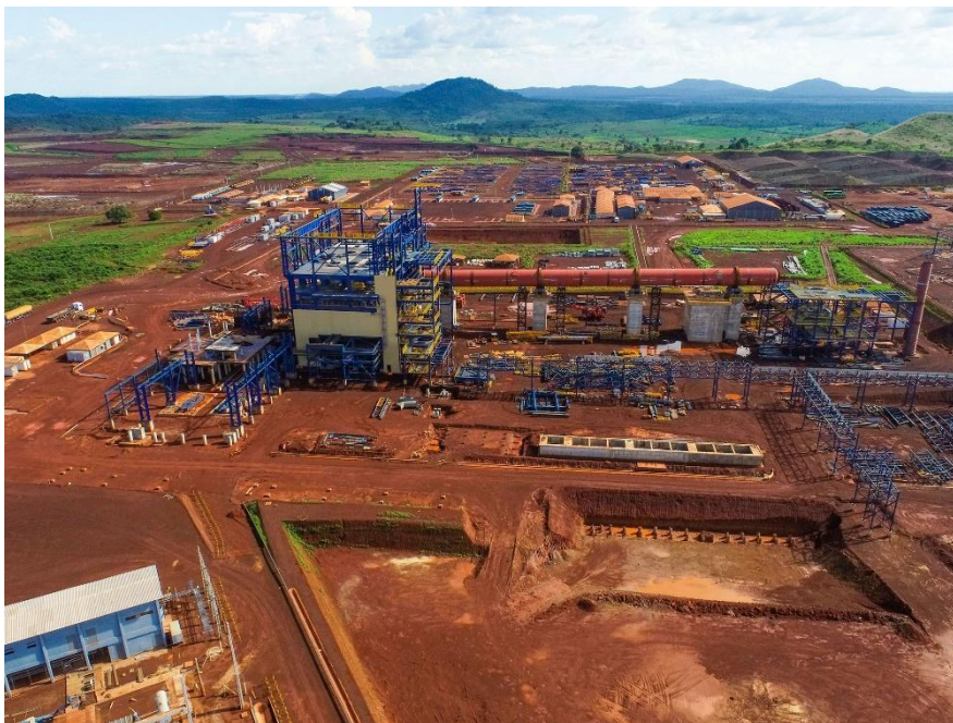
Figura 3 – Vista da montagem de estrutura metálica do Precipitador Eletrostático, do Forno Rotativo, do Forno Elétrico e do Refino.
