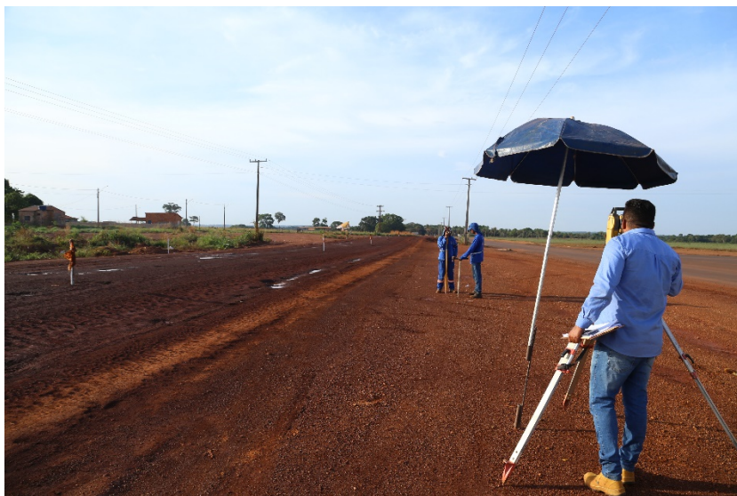
Foto 1: Trabalho da equipe de topografia, no trecho da PA-449 que será asfaltado
