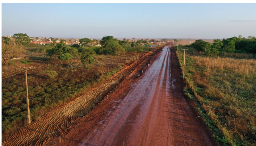
Foto 2: Serviços de reforço do subleito da rodovia iniciado na PA-449, como parte da obra de asfaltamento do trecho de 2 km
