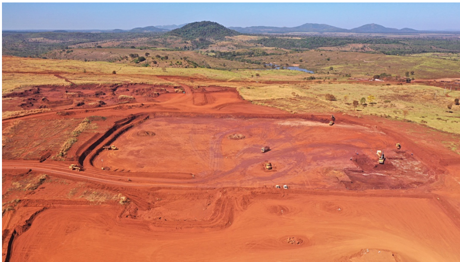
Figura 7 – Vista da cava Pequizeiro
