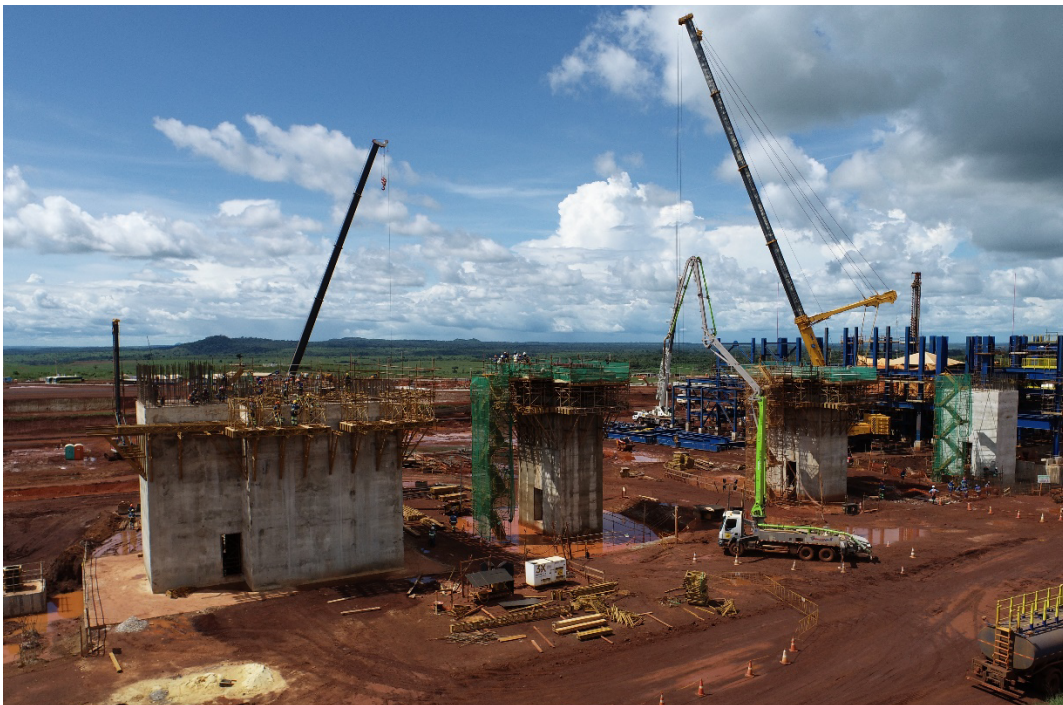
Figura 2: Os quatro pilares de 6m de altura para apoiar o Forno Rotativo, mostrando as formas deslizantes instaladas para moldar as seções superiores.
