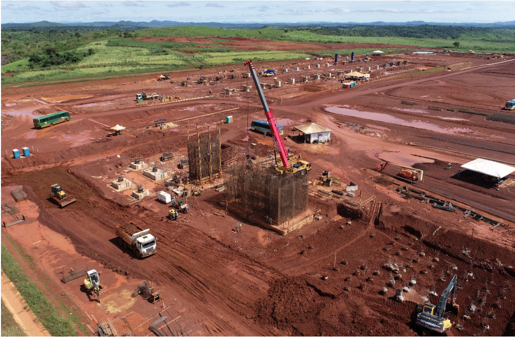
Figura 3: Fundações das colunas do secador, mostrando o trabalho em forma de aço pronto para a aplicação de concreto.
