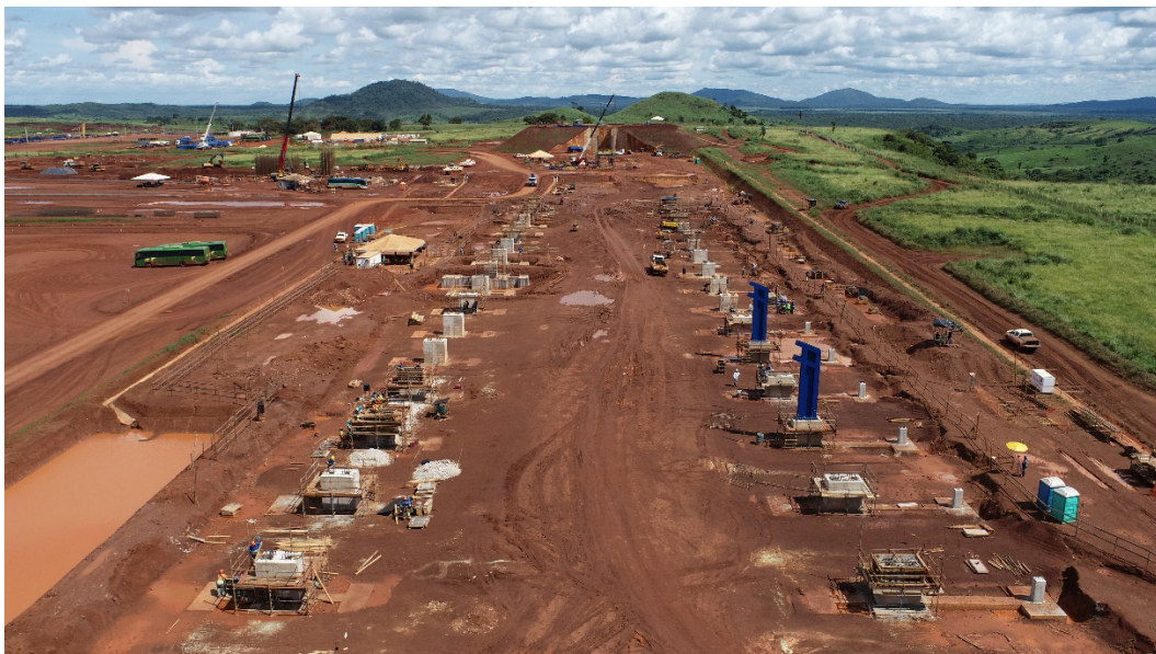
Figura 4: Obras de montagem de estrutura metálica em andamento no galpão de homogeneização.
